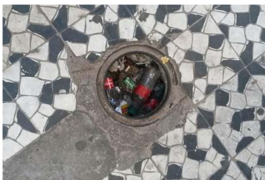
Figura 5. Obstrução de tubulações pelo acúmulo de resíduos sólidos na regional Centro (A) e enchente na Avenida Bento Gonçalves na regional Centro (B) Fonte: Acervo dos autores (2015)
