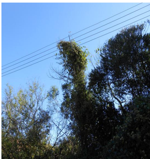
Foto 3. Arquivo Pessoal- galhos encostando na rede elétrica.
