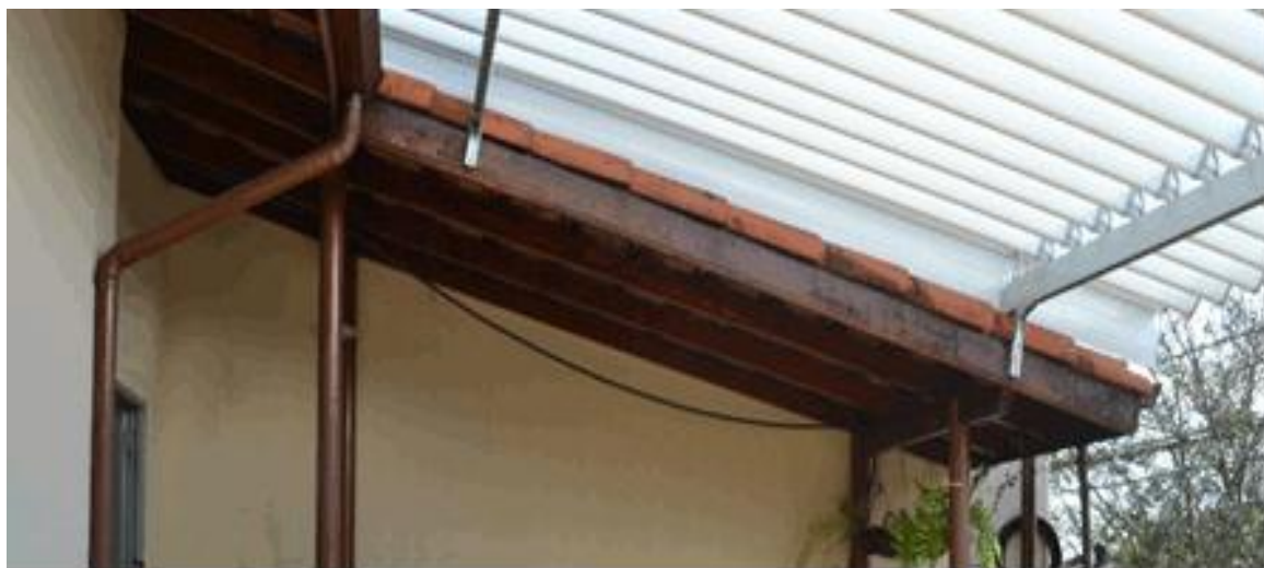
Figura 4: Canos de descida para a instalação da mini cisterna
