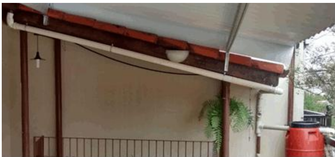
Figura 4: Canos de descida para a instalação da mini cisterna
