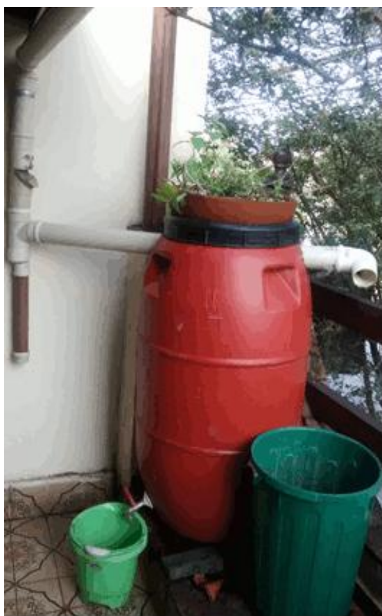
Figura 7: Instalação da Frente
