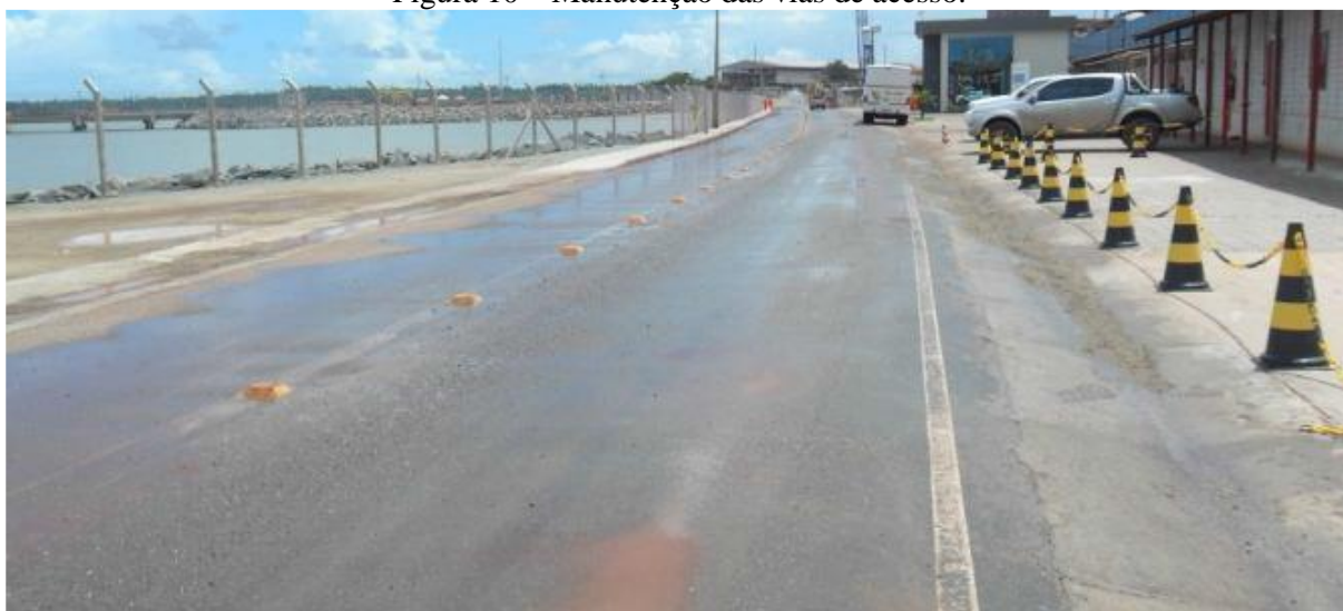
Figura 10 – Manutenção das vias de acesso.
