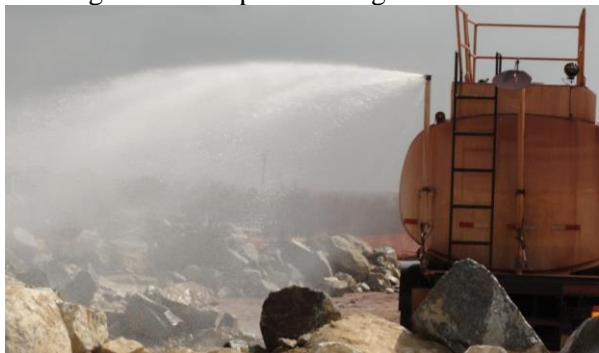
Figura 14 – Aspersão de água nos rachões.
