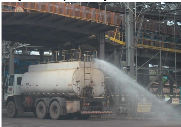
Figura 07 – Aspersão de água na via de acesso.
