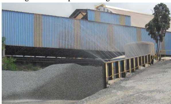
Figura 13 – Aspersão de água nas britas.
