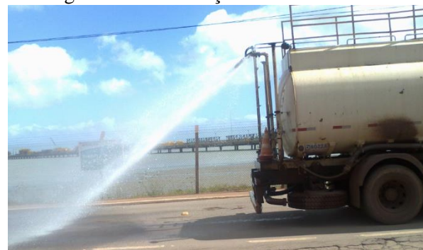
Figura 15 – Umectação nas vias de acesso.
