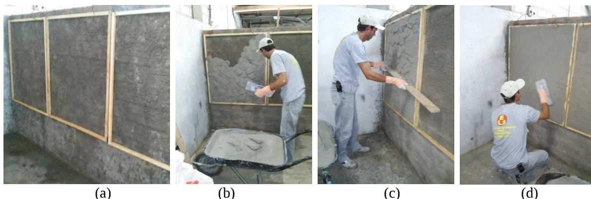
Figura 6 – Execução das argamassas - (a) painéis chapiscados; (b) lançamento; (c) sarrafeamento; (d) desempeno
