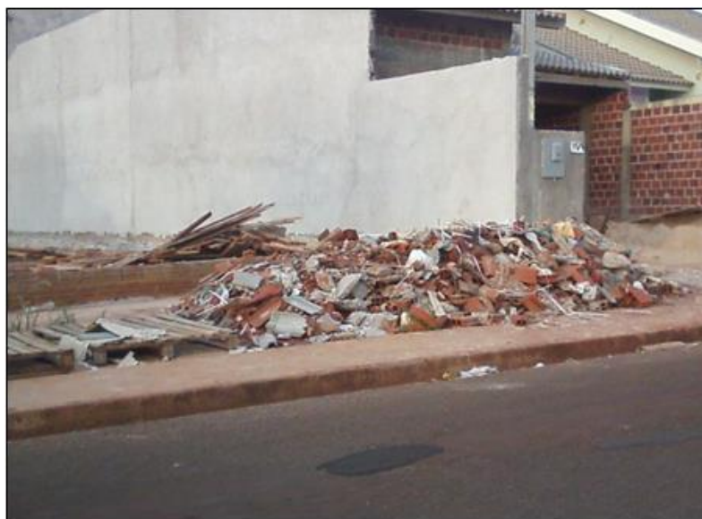
Figura 8: Armazenagem inadequada de resíduos da construção civil.
