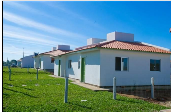
Figura 2: Casas geminadas e isoladas do conjunto habitacional em Forquilha, SC.
