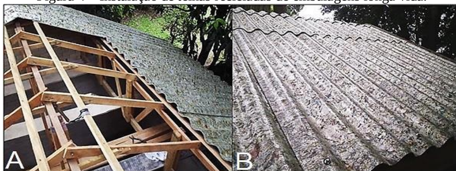
Figura 4 – Instalação de telhas recicladas de embalagens longa vida.
