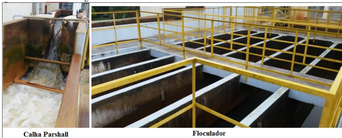
Figura 3 - Calha Parshall e floculador hidráulico da ETA.
