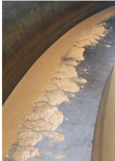
Figura 6 - Lodo sendo removido dos decantadores.
