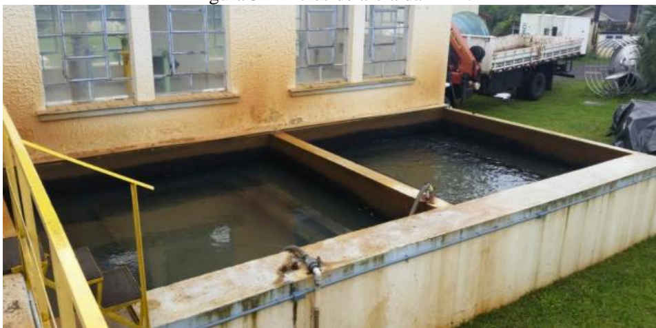
Figura 5 - Filtros de areia da ETA.
