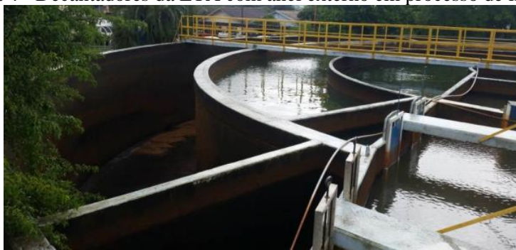
Figura 4 - Decantadores da ETA com anel externo em processo de limpeza.
