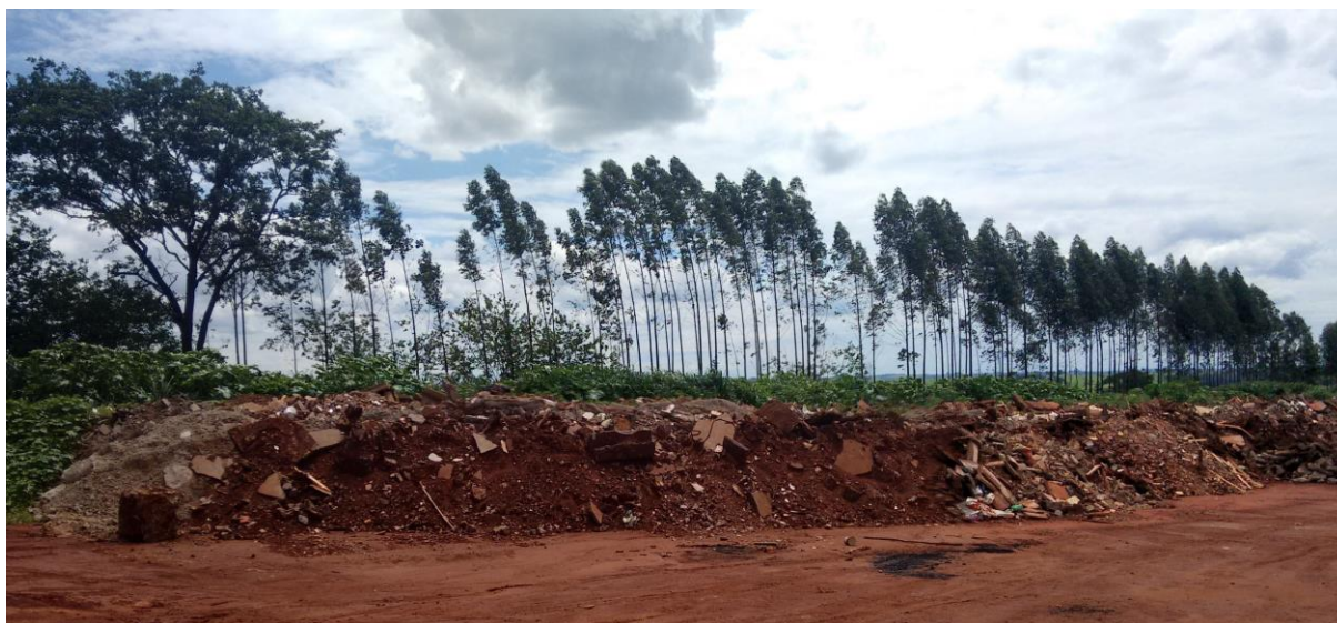
Figura 4 - Área de disposição de Resíduos de Construção Civil
