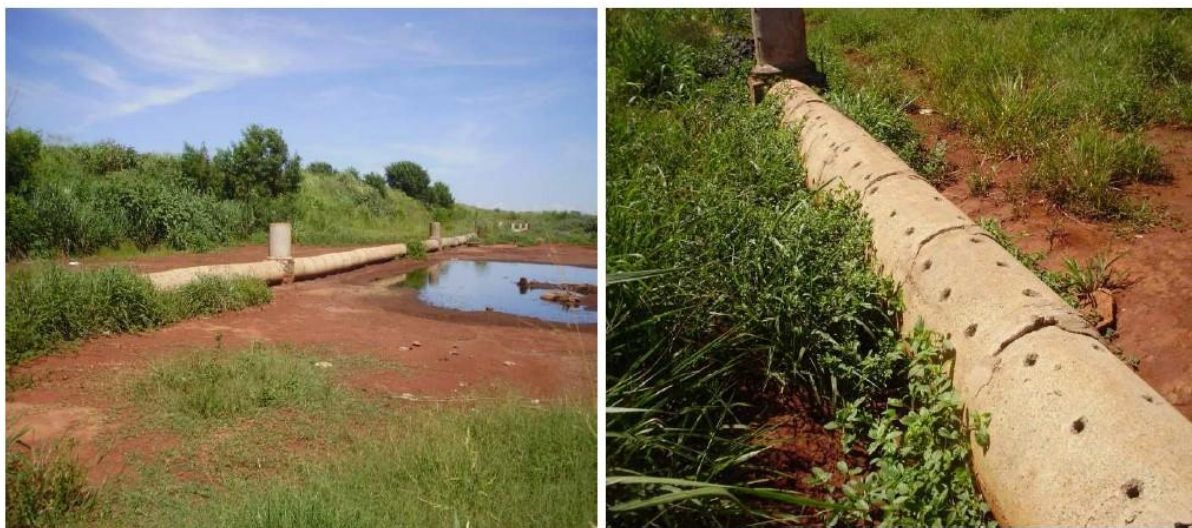
Figura 3 - Célula em construção sem impermeabilização adequada
