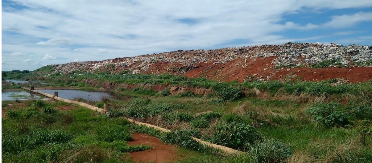
Figura 2 - Visão lateral do talude do aterro
