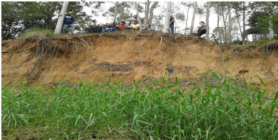
A areia carregada dos taludes em erosão provoca o assoreamento do curso de água (figura 3), que pode barrar o fluxo de água a ponto de provocar o transborde do arroio e resultar em alagamentos e enchentes em diversos pontos da cidade.
