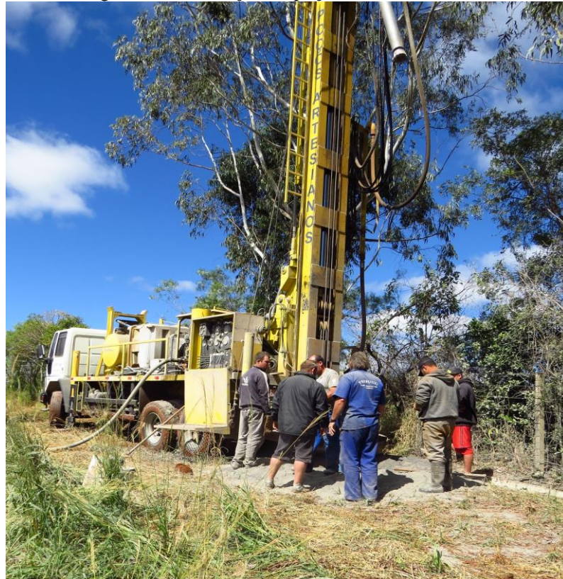
Figura 2 – Perfuração de poço de monitoramento
