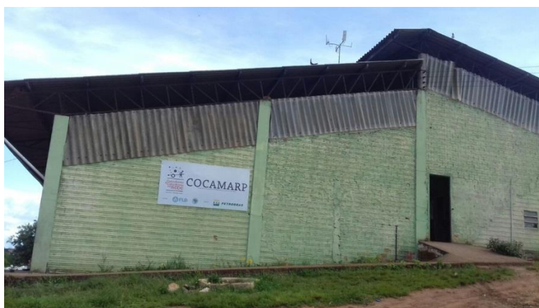
Figura 1 – Prédio da Cooperativa de Catadores de Materiais Recicláveis de Rio Pardo – RS (COCAMARP)
