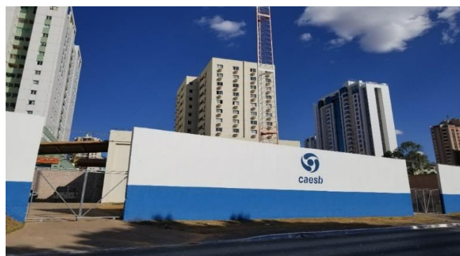
Figura 1: Vista frontal da unidade Estação Elevatória de Esgotos de Águas Claras -DF
