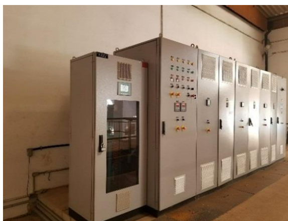
Figura 3: Painel de comando elétrico da Elevatória de Esgoto de Águas Claras- DF
