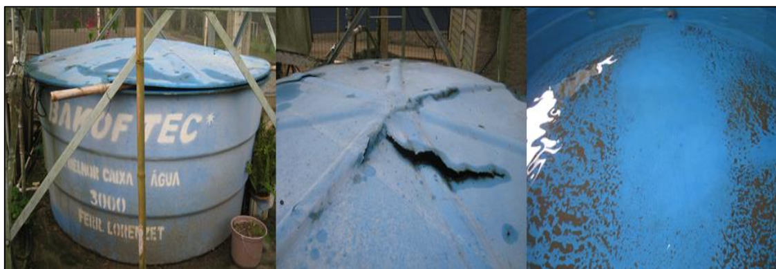
Figura 2 - Condições externas e internas do reservatório da água consumida na Escola 1.
