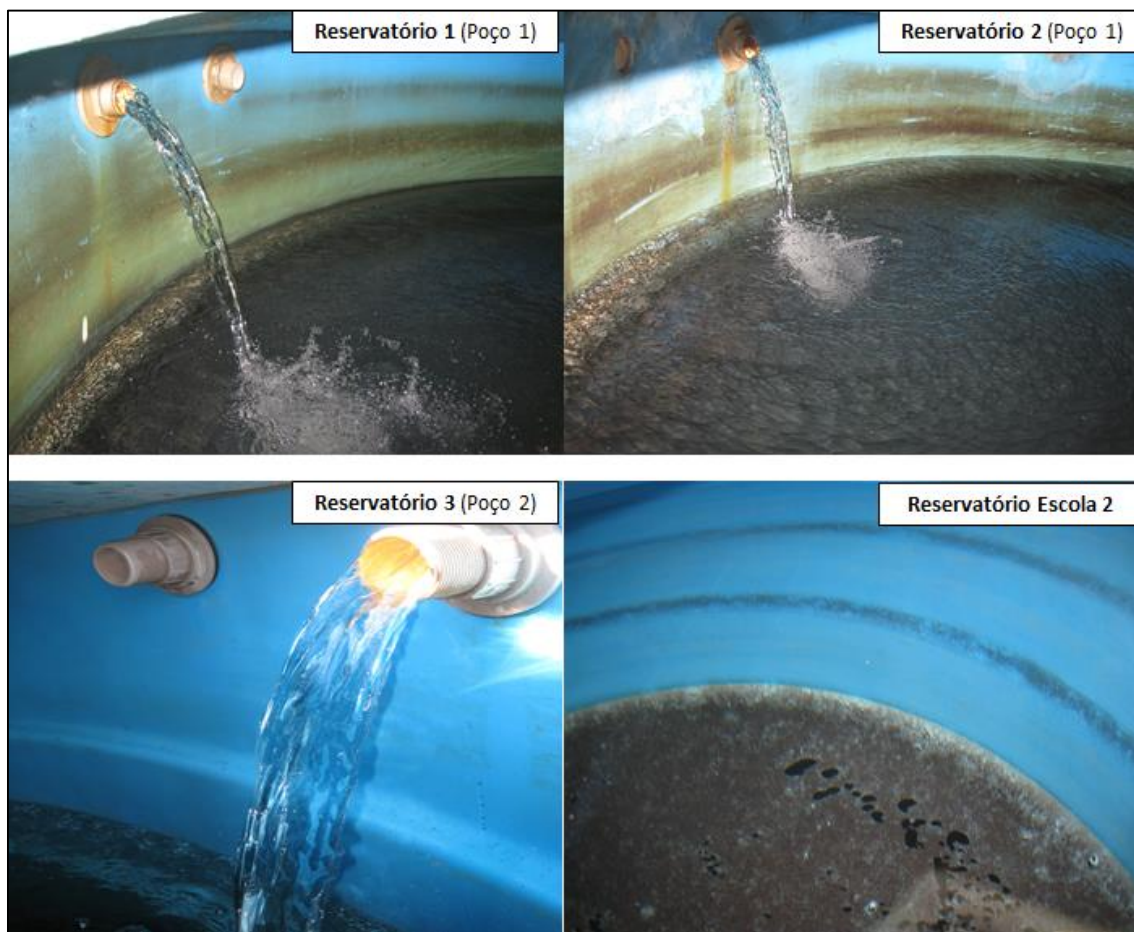
Figura 3 - Parte interna dos reservatórios do sistema de distribuição da água consumida na Escola 2.
