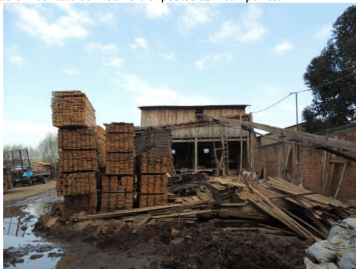
Figura 3 – Pátio da empresa B com piso inadequado em contato com os resíduos e produtos finais.
