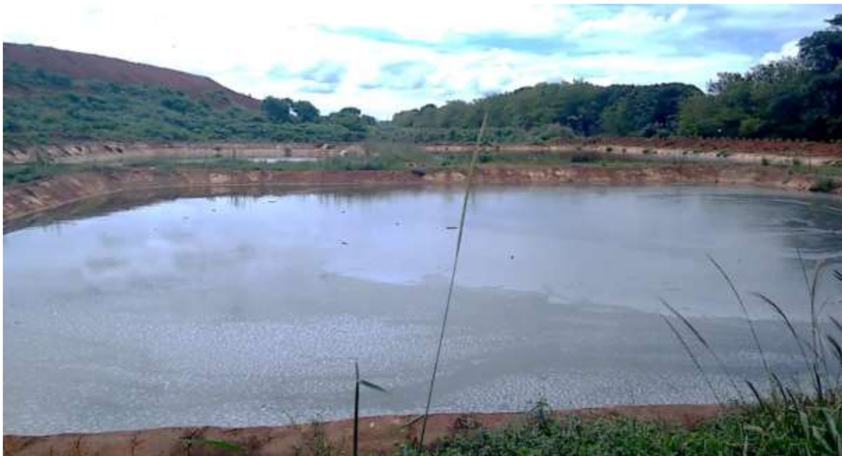
Figura 6: Sistema de tratamento de chorume atualmente instalado no aterro.
