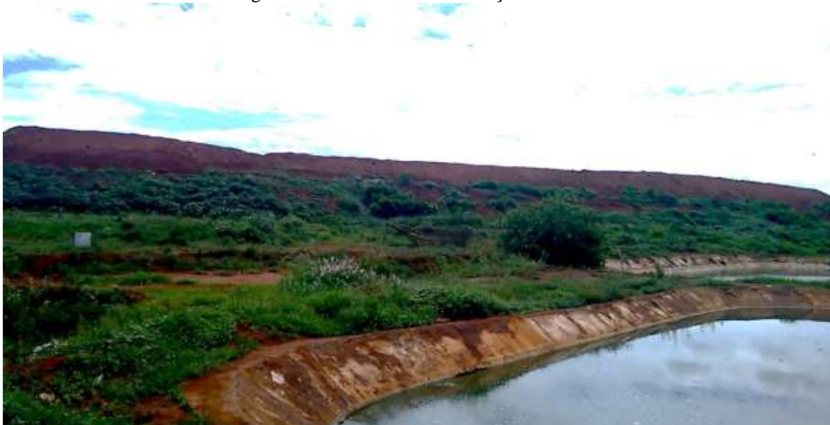
Figura 3: Visão Frontal do Maciço de Resíduos no Aterro.
