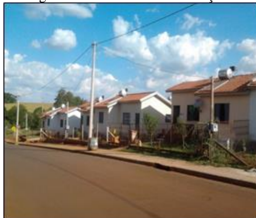
Figura 2 – Fachadas das edificações.
