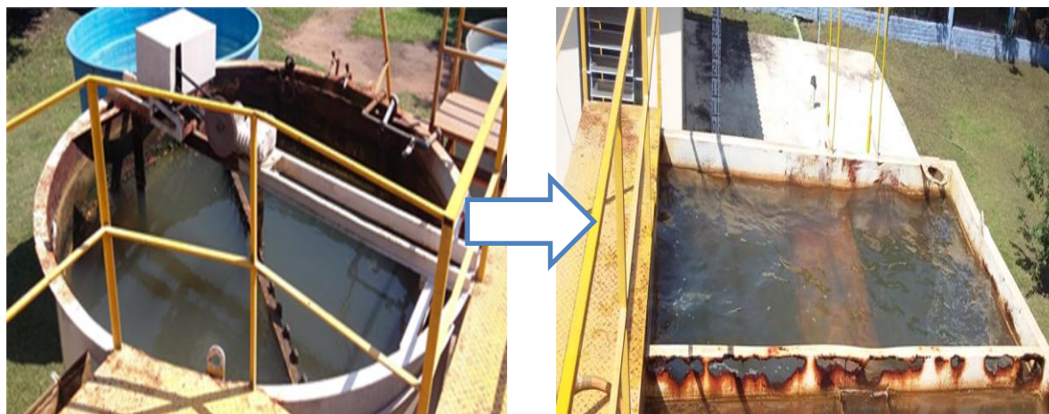
Figura 12 - Coagulação/sedimentação seguida de filtração.
